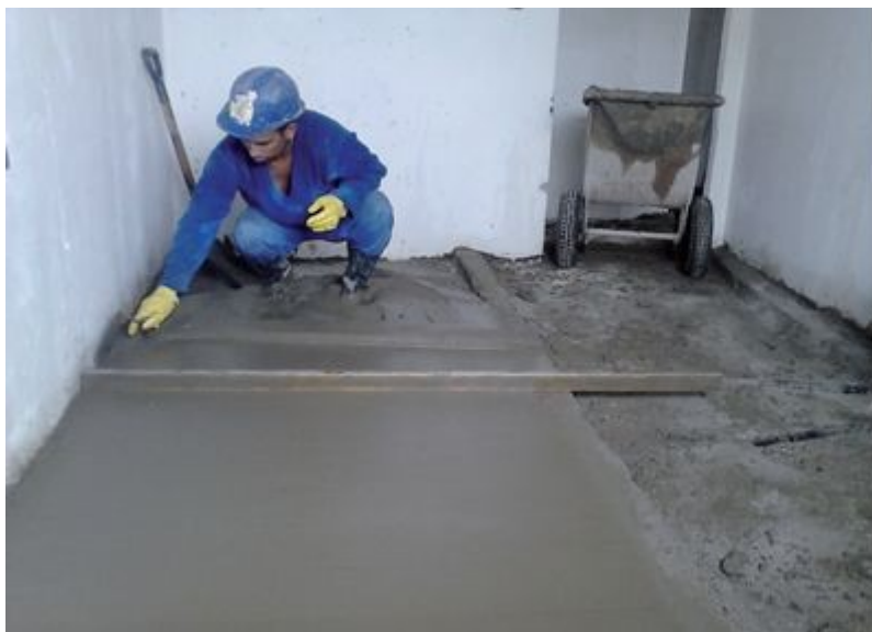
Após executar, com a ajuda de uma empresa especializada, um pavimento-modelo com contrapiso autonivelante, construtora assimilou a técnica de execução e passou a utilizar mão de obra própria no serviço
