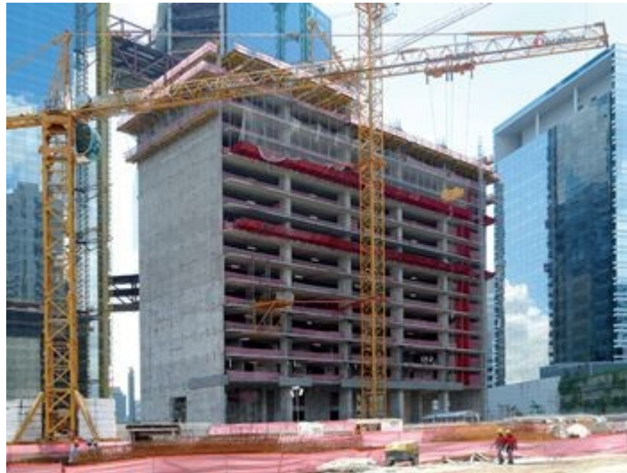
Para a construção de uma torre comercial que compõe o Parque da Cidade, em São Paulo, estão sendo empregadas três guias. A intenção da construtora é evitar gargalos de produção da estrutura, que tem ciclo de seis dias e utiliza lajes alveolares pré-fabricadas
