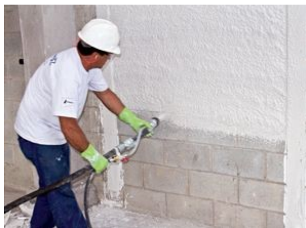
Qualificação dos aplicadores é um dos desafios para o uso de gesso projetado, segundo engenheiro da Tecnisa
