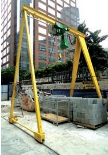
Pórticos rolantes aceleraram a obra e viabilizaram a carga e descarga em terrenos estreitos e com restrição de tráfego. Grua basculante permitiu grandes comprimentos de lança e pequenos giros
