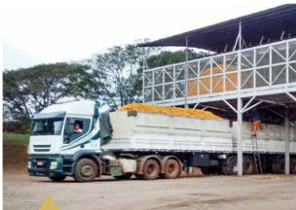
Bin instalado na entrada da propriedade
