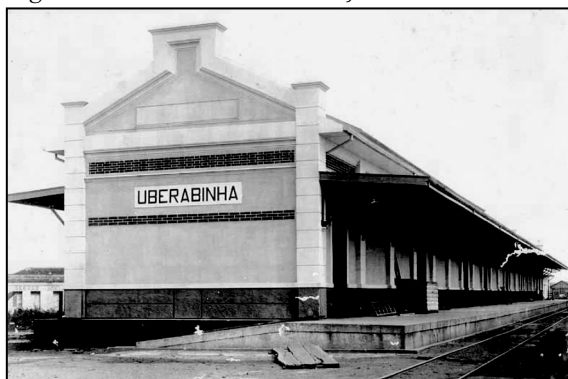
Figura 3 – Vista Parcial da Estação de Uberabinha da Mogyana (s/d).
