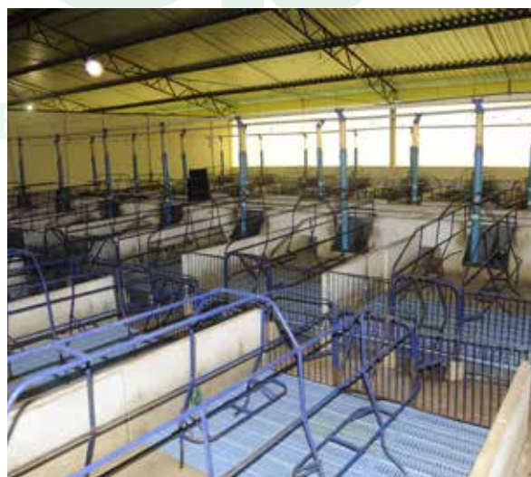
Foto 1 – Sala maternidade limpa para alojamento de matrizes pré-parto
