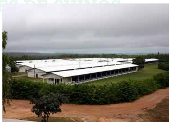
Foto 2 - Cerca viva de proteção (barreira física) das granjas
