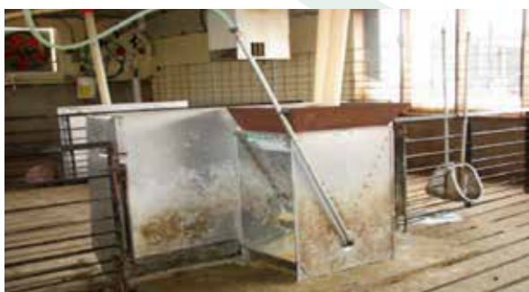
Foto 4 - Comedouro com bebedouro embutido
