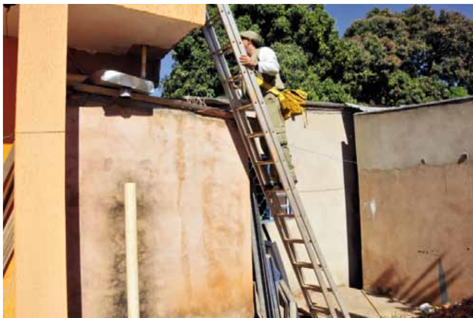
Figura 11. Os depósitos elevados deverão ser inspecionados, devendo haver apoio para esta atividade.
