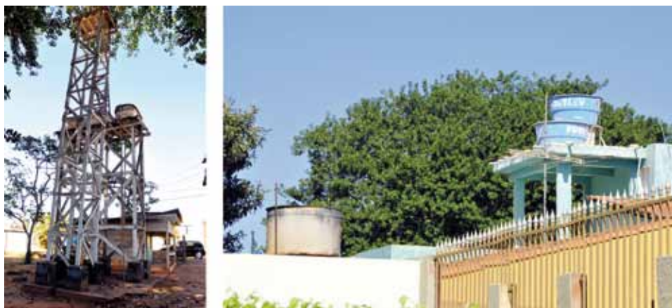
Figura 12. Depósitos de água elevados.
