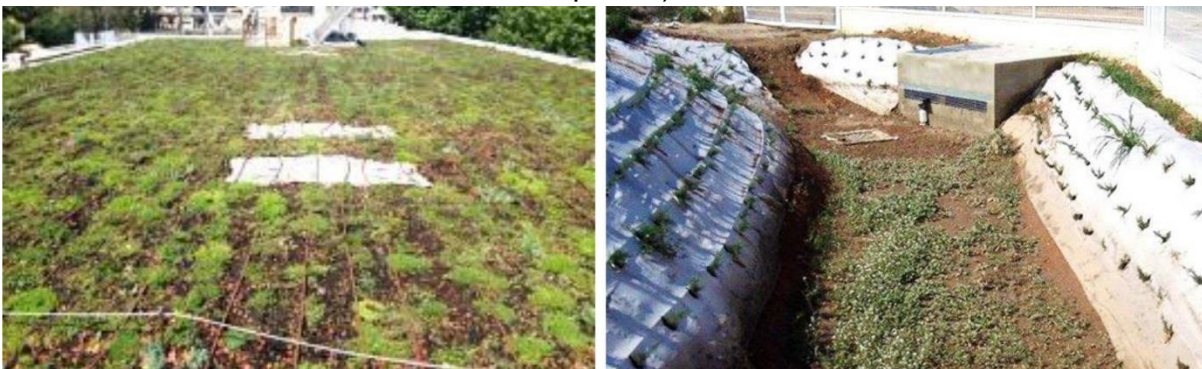
Foto 1.5 – Sistemas SUDs propostos no Projeto Aquaval; à esquerda telhado verde instalado na cobertura de um prédio e, à direita, trincheira vegetada (Xàtiva, Espanha)
