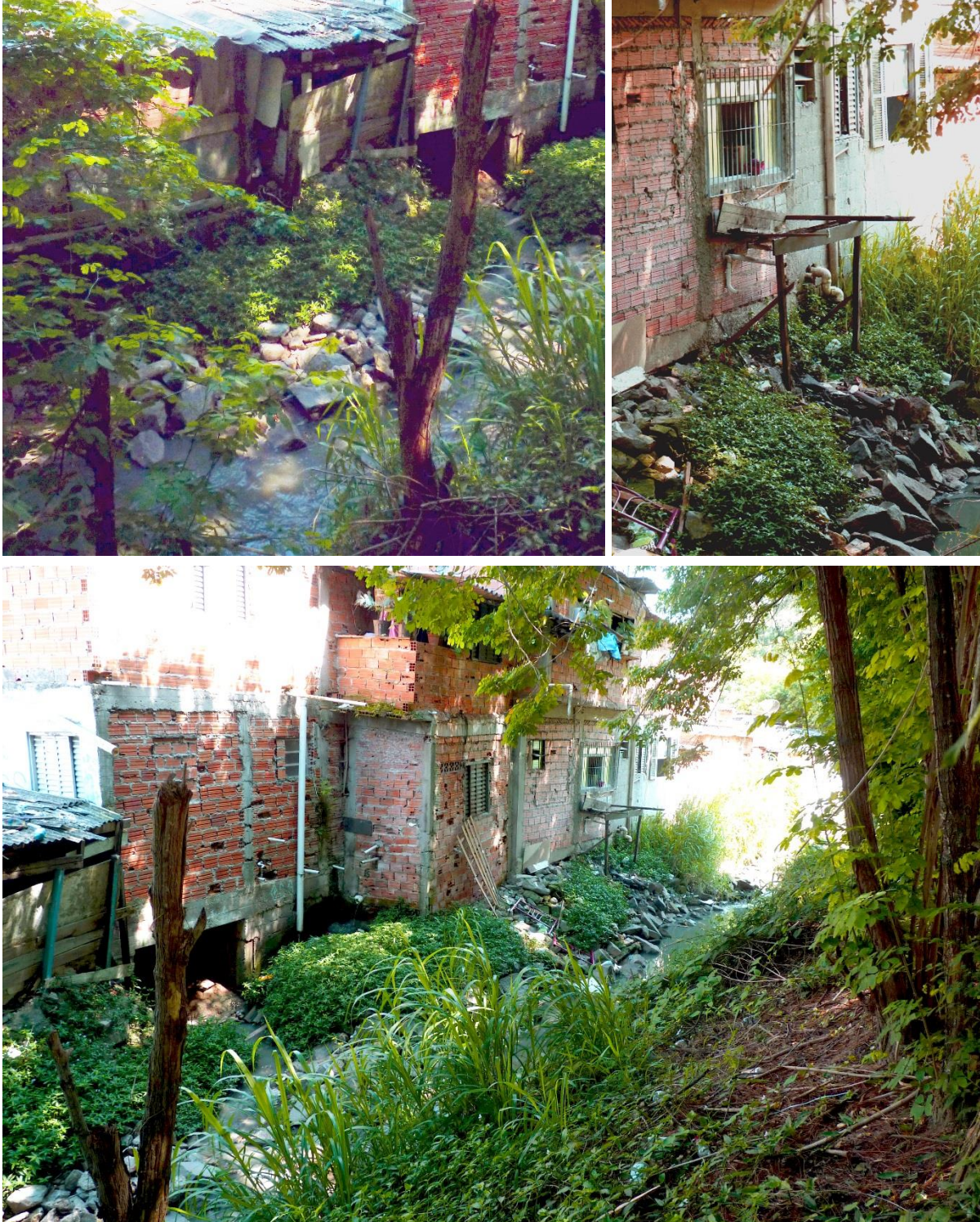
Foto 4.12 – Vistas de assentamentos irregulares ocupando as margens e o próprio curso d'água do Córrego Espanhol, na Bacia do Jaguaré
