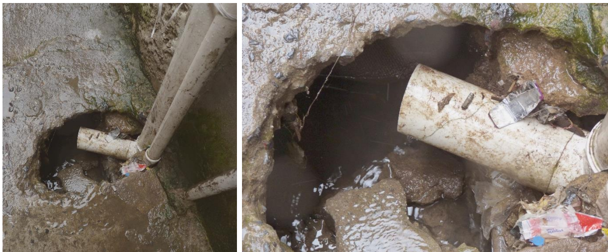
Foto 4.14 – Efluentes domésticos lançados no que era o antigo curso afluente do Córrego Espanhol, na Bacia do Jaguaré
