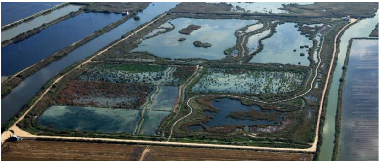
Foto 1.4 – Alagado Construído de Fluxo Horizontal instalado na lagoa Albufera (Valencia, Espanha) integrado ao projeto LIFE-Albufera financiado pela Comissão Europeia
