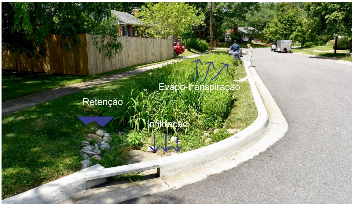
Foto 1.2 – Imagem de uma bio-valeta instalada na lateral de uma calçada em Montgomery County (Maryland, EUA) e demarcação dos principais processos hidrológicos associados
