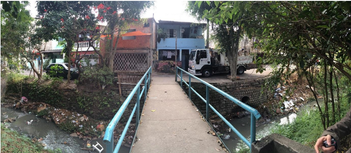
Foto 4.16 – Vista da ponte e casas próximas ao Córrego Água Podre
