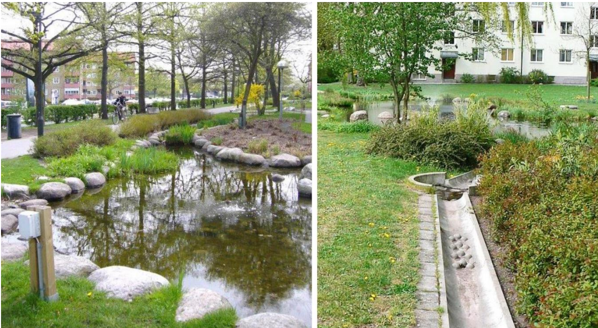
Foto 1.3 – À esquerda, bacia para retenção da água e, à direita, conexão entre o essa e o sistema de captação d'água em Augustenbourg (Malmo, Suécia)
