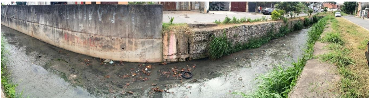
Foto 5.1 – Pontos de lançamento de esgoto pluvial no córrego Água Podre
