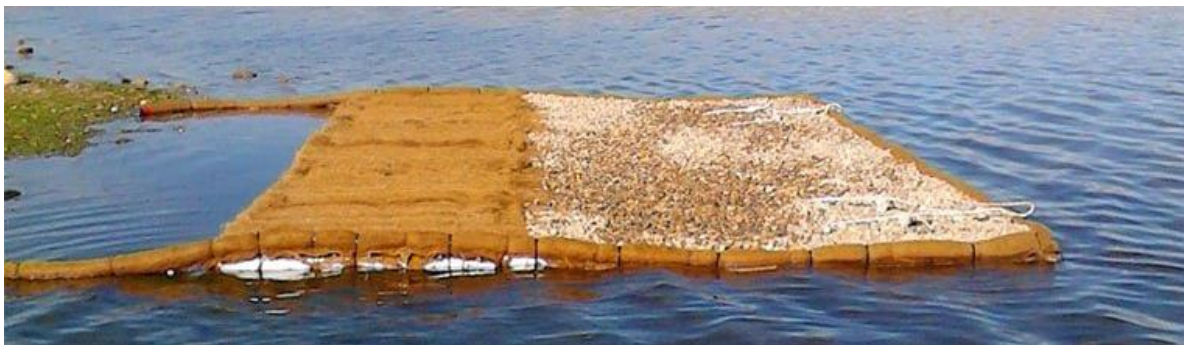
Foto 3.1 – Sistema de Ilha flutuante para tratamento da água coberto com fibra de coco na Colombia
