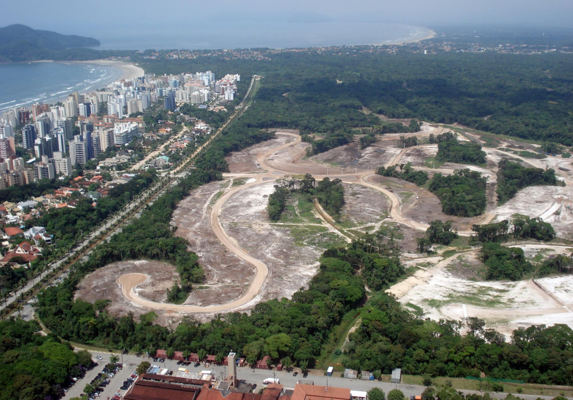
Preparação para implantação de loteamento. Bertioga, SP. Foto Ulisses Sardão, 2007.
