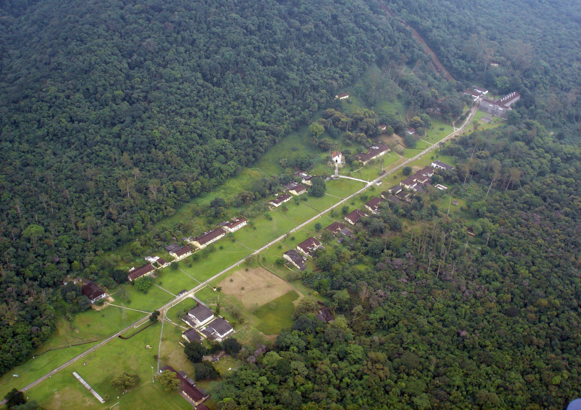
Instalações da usina hidrelétrica de Itatinga, Bertioga, SP. Foto Kim Ordonha, 2007.
