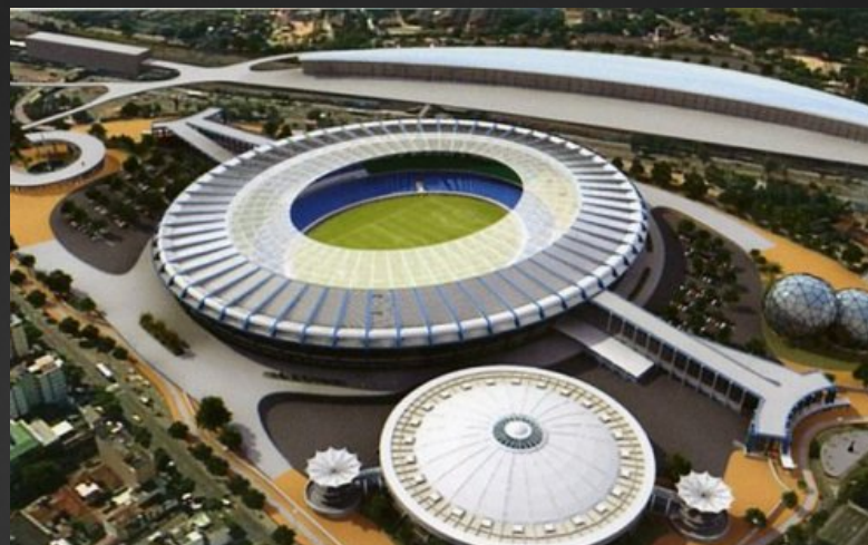
Estádio Maracanã – Rio/RJ LEED NC v.3 – Fev/11
