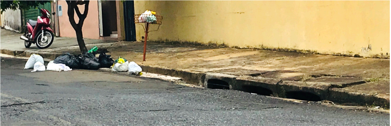
Figura 1. Exemplo de risco de poluição difusa por esgoto pluvial e resíduos sólidos, transportados diretamente para a rede de drenagem, sem tratamento. Este risco ainda não foi incorporado aos levantamentos oficiais de falta de saneamento básico nem às demandas não-consuntivas dos 5.570 municípios brasileiros. Foto: E. M. Mendiando (2019)
