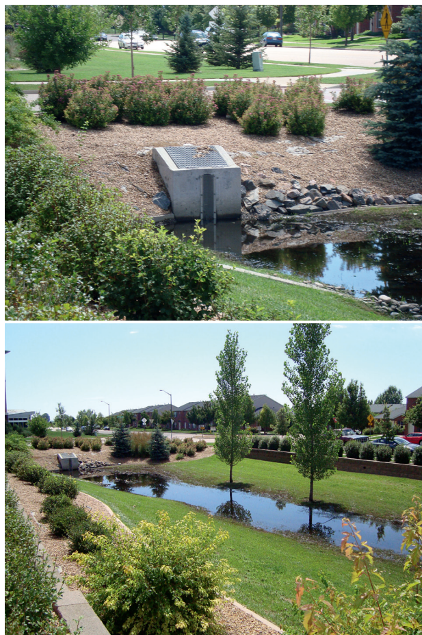
Figura 5.5 - Exemplos de reservatório de detenção (Colorado, EUA)
