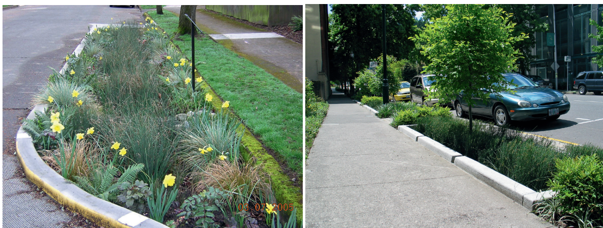
Figura 5.14 - Exemplo de Vala de infiltração/retenção (Portland, EUA)
