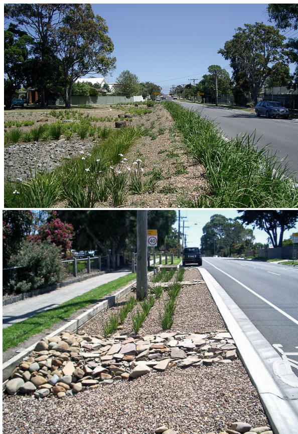
Figura 5.17 - Exemplo de trincheira de infiltração (Kingston, Melbourne, Austrália)
