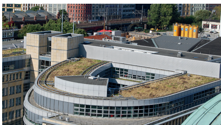
Figura 5.12 - Exemplos de telhados reservatórios / telhados verdes (Suíça e Berlin, Alemanha)
