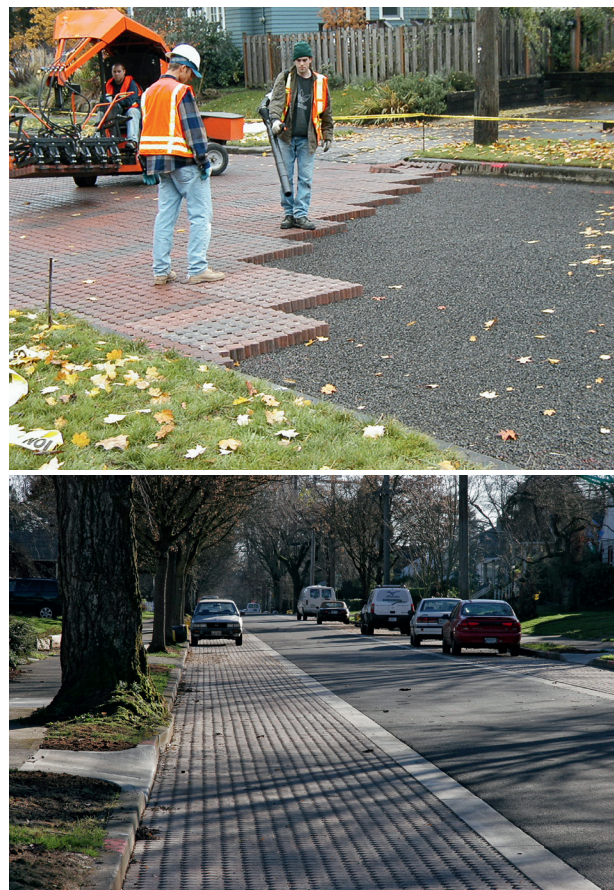
Figura 5.10 - Exemplo de pavimento permeável (Portland, EUA)
