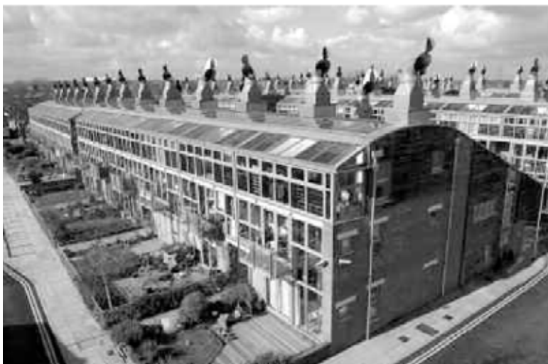
O empreendimento imobiliário BedZED, em Hackbridge, Londres, Reino Unido
