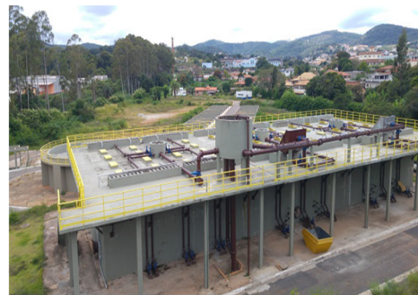
Figura 4.15 – Ilustrações esquemáticas reatores UASB prismáticos retangulares
