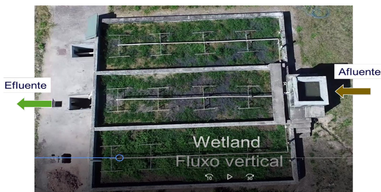
Figura 4.39 – Vista superior do primeiro estágio do Sistema Francês, composto por três unidades em paralelo e tratando esgoto bruto com um equivalente populacional de 100 habitantes
