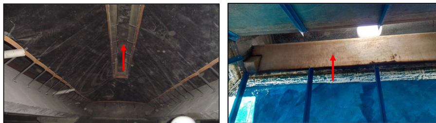
Figura 6.6 – Separadores trifásicos com canaletas internas para remoção de espuma
