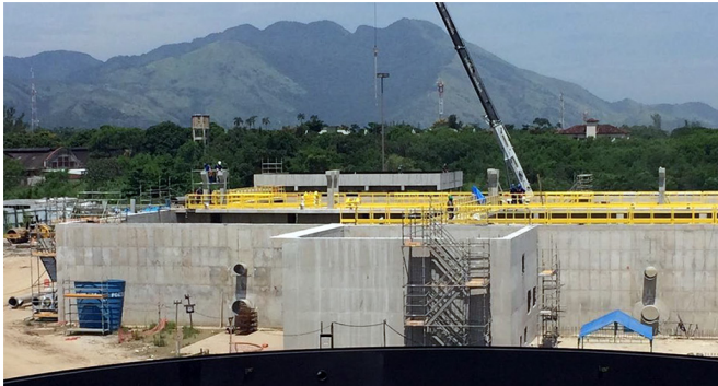
Figura 4.49 – Construção da ETE Deodoro com tecnologia Nereda no Rio de Janeiro
