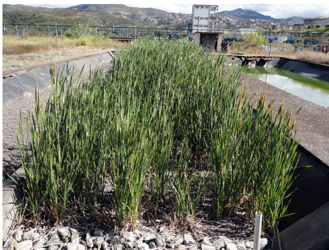
Figura 4.38 – Vista frontal de um wetland construído de escoamento horizontal subsuperficial, tratando efluente de reator UASB, com um equivalente populacional de 50 habitantes, plantado com taboa Fonte: Centro de Pesquisa e Treinamento em Saneamento – CePTS UFMG/Copasa (2018)
