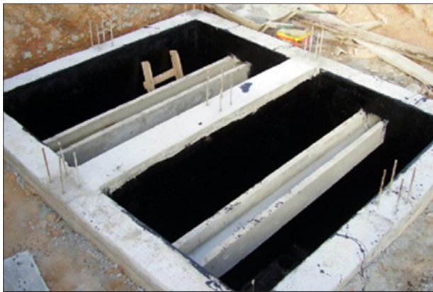
Figura 4.12 – Filtro anaeróbio em concreto moldado in loco
