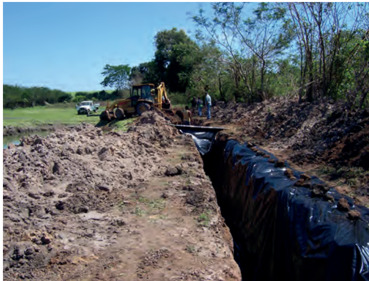
Figura 12 - Barragem subterrânea.
