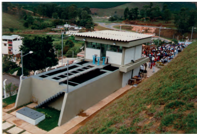
Figura 30 - Estação de Tratamento de Água - ETA de ciclo completo.
