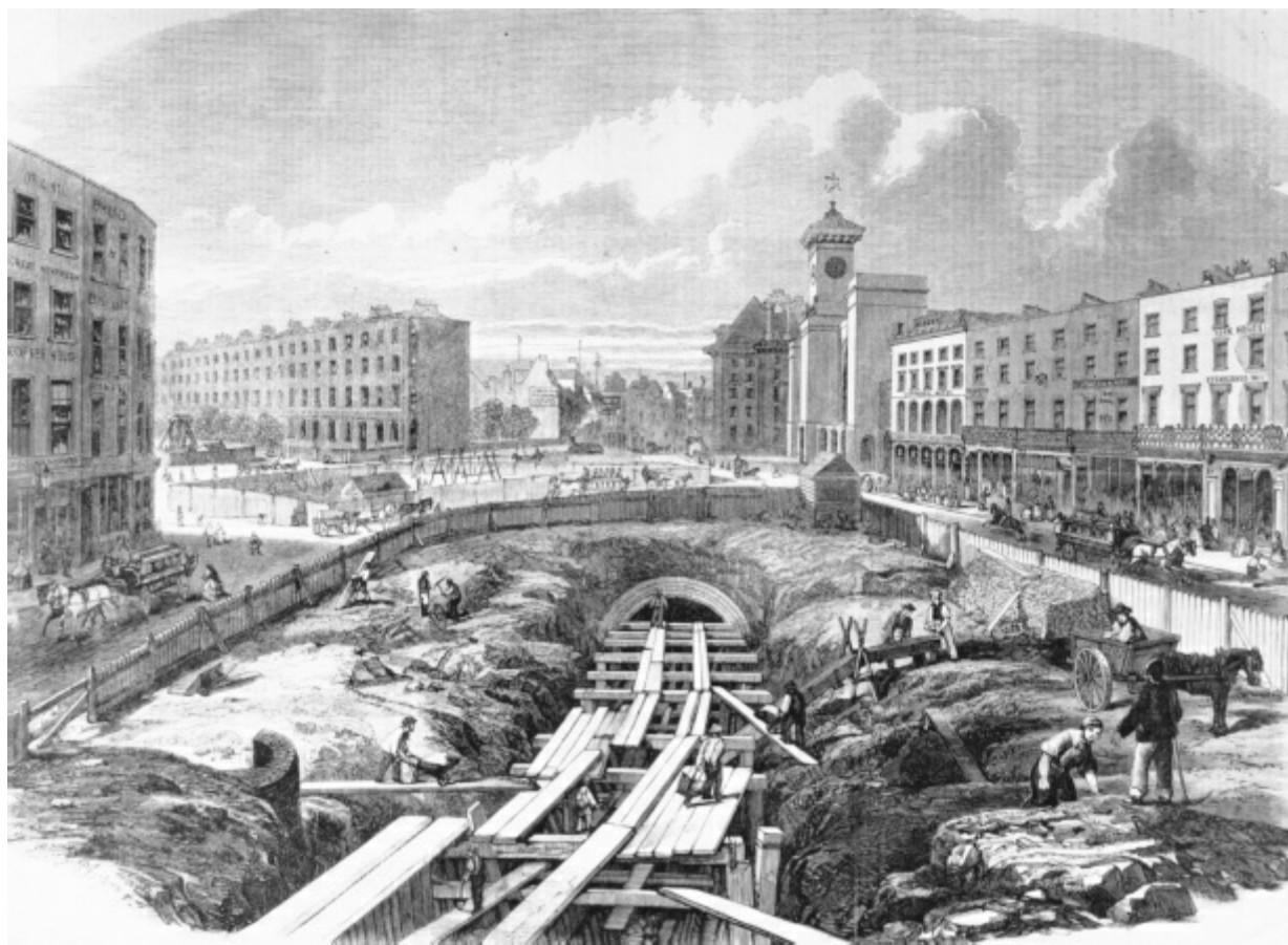
Operários trabalham na Metropolitan Line do metrô, sob as obras da estação King's Cross, em Londres.
