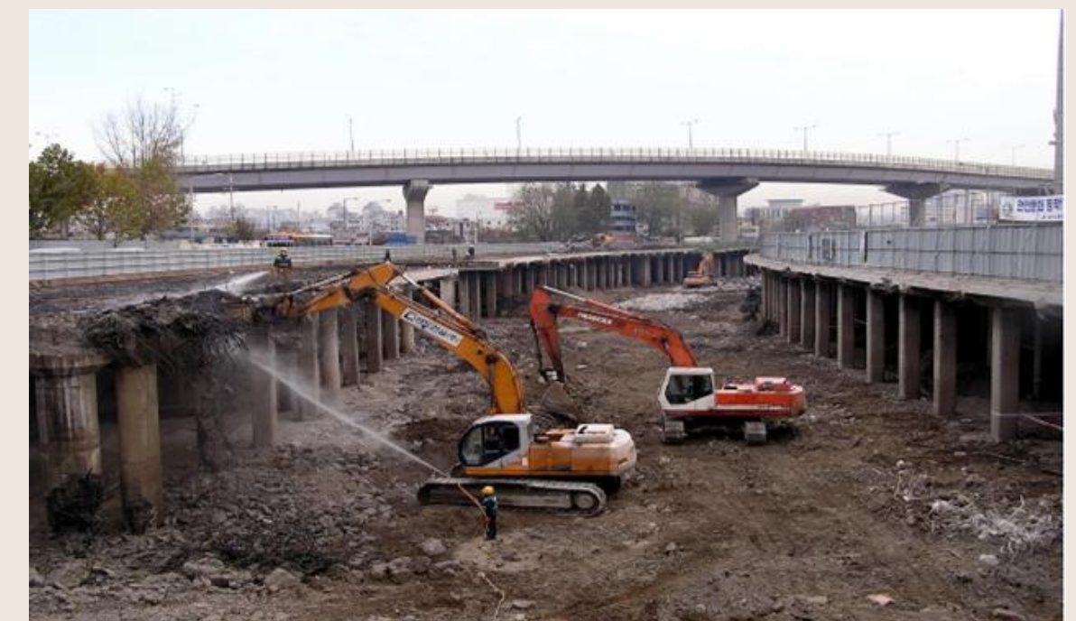
Figura: Desmonte do viaduto, Fonte: RYU, 2016.
