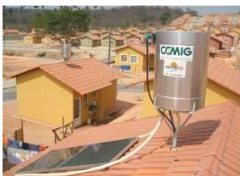
Figura 2 - Sistema de Aquecimento instalado em casas. Crédito da foto: Aquecemax
