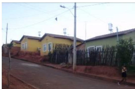
Figura 4- Casa e aquecedor solar em Itatiaiuçu – MG. Crédito da foto: Izadora C. Corrêa Silva.
