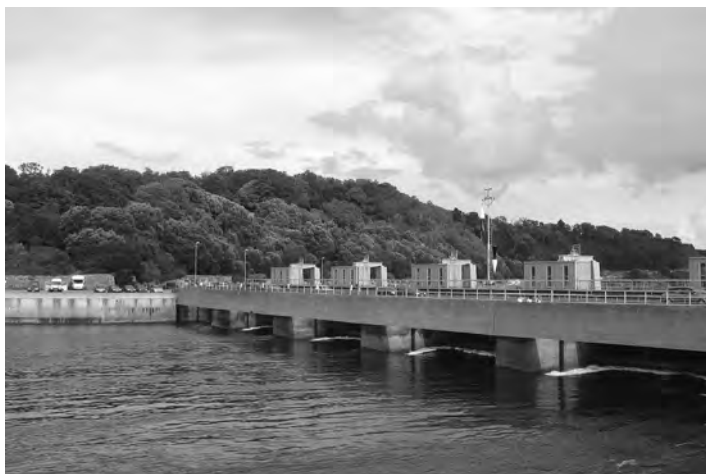
Barragem da usina de energia das marés do estuário do Rio Rance, Brittany, França. A usina está em operação desde 1966.
