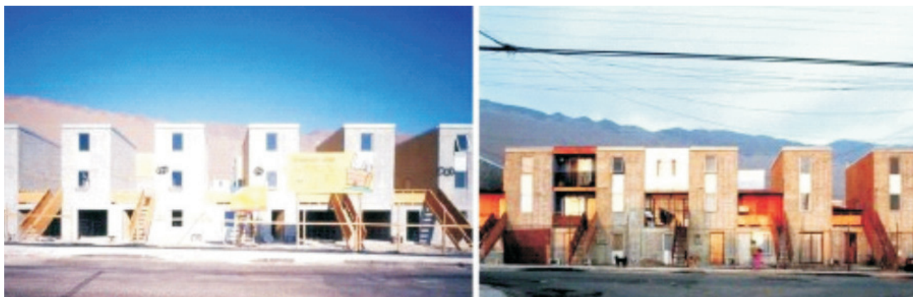
Figura 10 — A Quinta Monroy, como construída e após intervenção dos usuários. Exemplo de arquitetura projetada para permitir a expansão de área. Fonte: Elemental Chile ( www.elementalchile.cl ).
