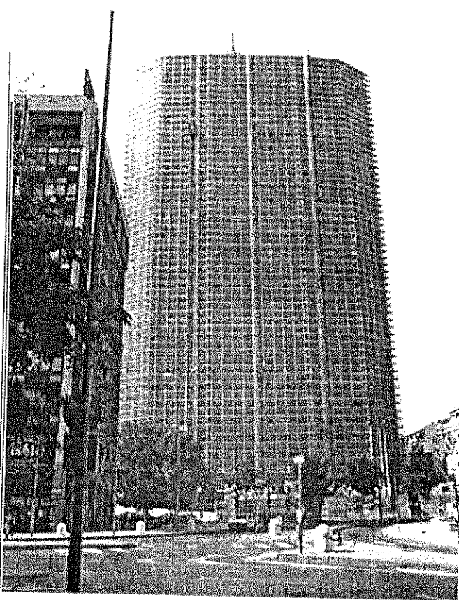
Fig. 7. O Arranha-céu envolvido pelos andaimes durante os trabalhos de restauração das fachadas (fevereiro de 2003); além dos elevadores correspondentes às "pontas", foram montados outros três em cada uma das fachadas para facilitar a movimentação dos materiais durante as operações de desmonte e remontagem dos painéis curtain wall .
