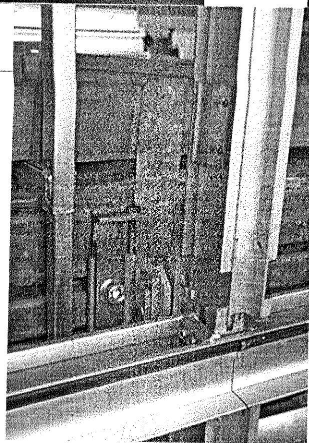
Fig. 9. Pormenor de uma junção montante-travessa no ponto de ancoragem, depois da restauração; sucessivamente serão remontados os Carter dos montantes e os painéis, transparentes e spandrel . Note-se o elemento para firmar os vidros acrescentado ao montante para permitir uma fácil inserção dos novos vidros duplos.
