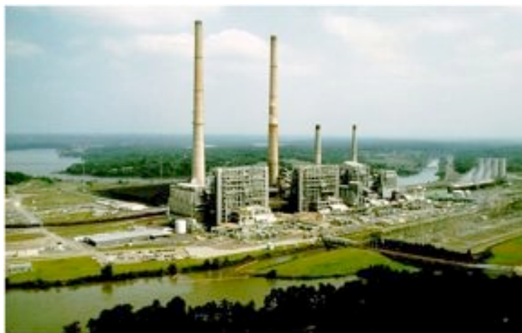
Central termoelétrica a carvão
