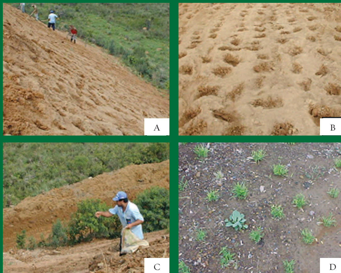
Figuras 25: Abertura das covetas com enxada (A), covetas com espaçamento médio de 30 cm (B), sementeira (C) e emergência das espécies de adubo verde (D).
