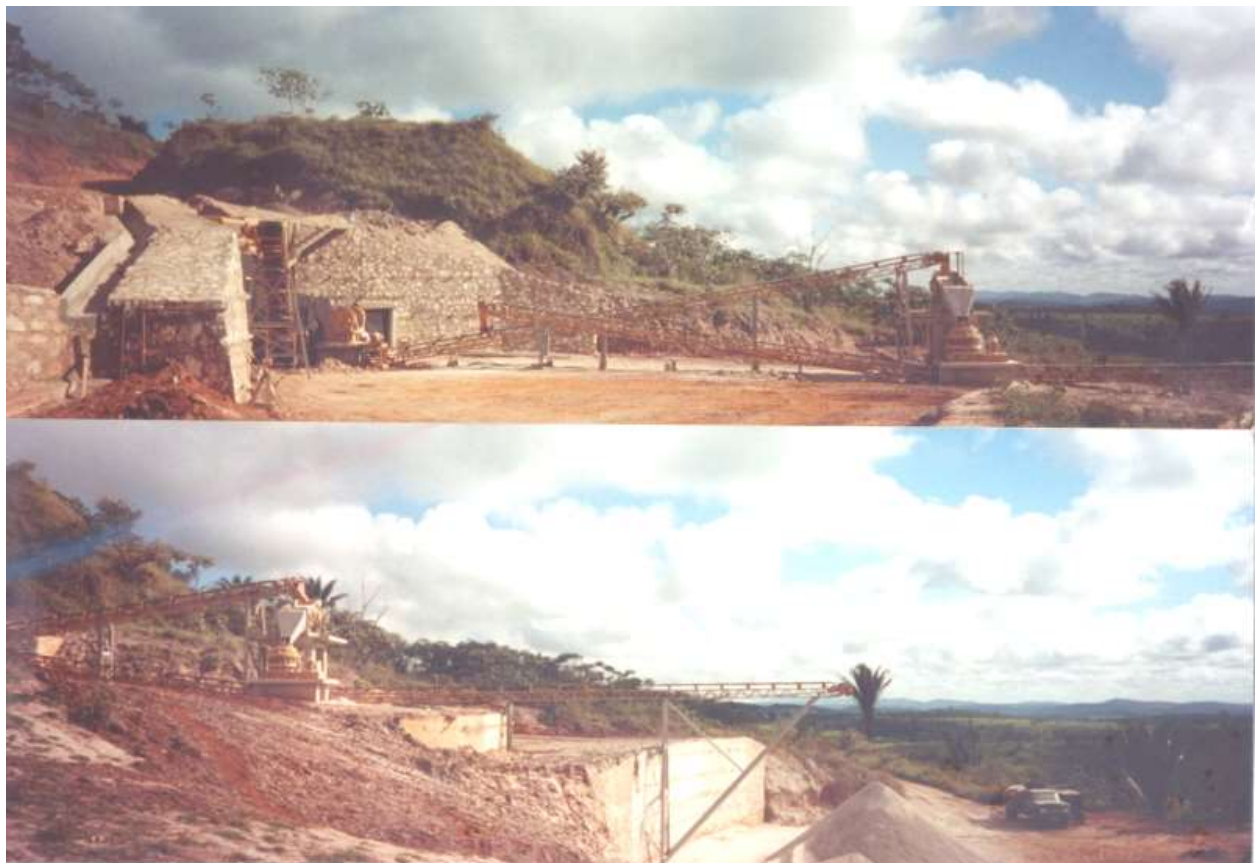
Figura 2 – obra executada e em operação
