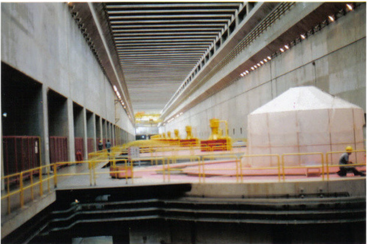
Vista interna da Casa de Força
