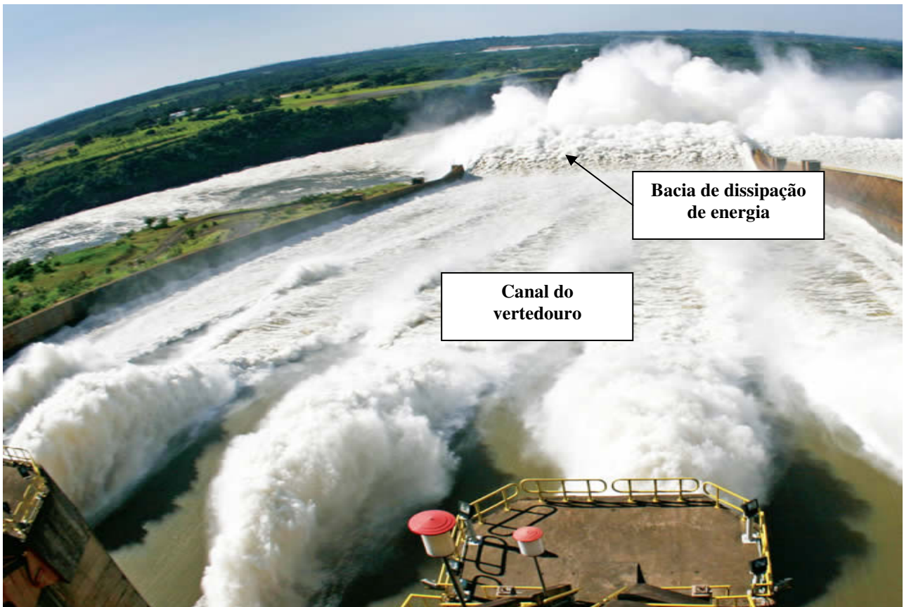
Vista do canal do vertedouro e bacia de dissipação de energia
