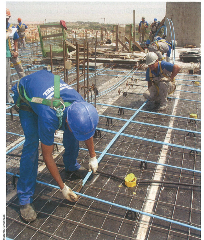
Solução para vencer grandes vãos, as lajes protendidas com cordoalhas engraxadas e plastificadas facilitam a execução, dispensando bainhas metálicas e injeção de nata de cimento
