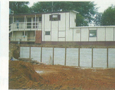
Foto 5 – Na primeira etapa, a escavação deve alcançar a primeira laje do subsolo
