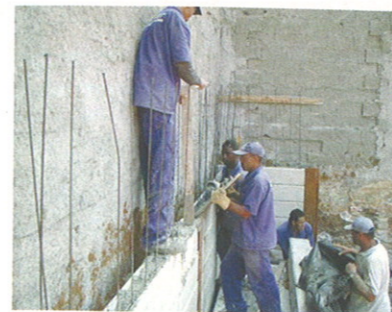
Foto 6 – O "miolo" é preenchido de concreto a cada trecho montado
