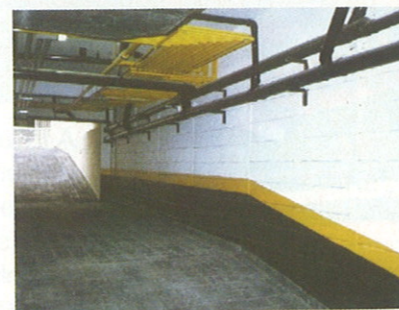
Foto 2 – As placas não requerem outro acabamento, basta a pintura
