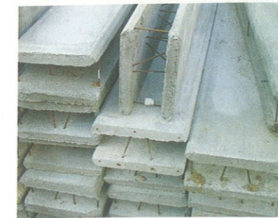
Foto 4 – As placas são pré-moldadas separadas por uma treliça
