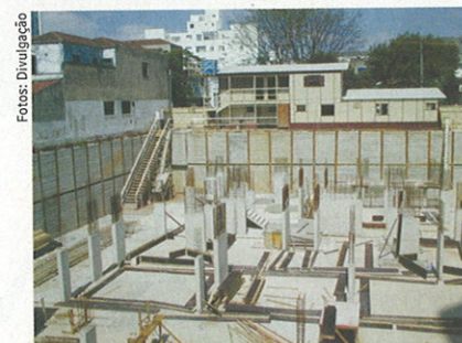
Foto 1 – Escavados os subsolos, o edifício é construído como uma caixa
