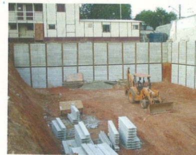
Foto 7 – A concretagem de todo o perímetro se faz pelo vão da laje superior
