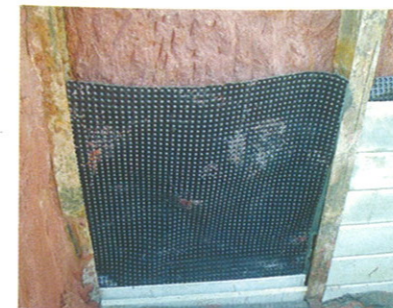
Foto 3 – Mantas geotêxteis permitem drenar o terreno pela parte de trás
