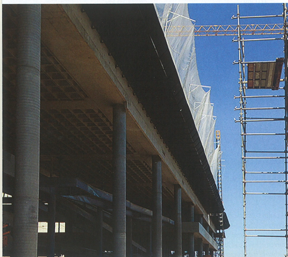
Laje nervurada em execução da fábrica da Natura, às margens da Rodovia Anhanguera, em São Paulo. Com 33 mil m 2 , o edifício tinha como desafio balanços de 8 m nas lajes. A opção pelo sistema de laje nervurada contribuiu para a entrega antecipada da obra, 60 dias antes do prazo previsto
