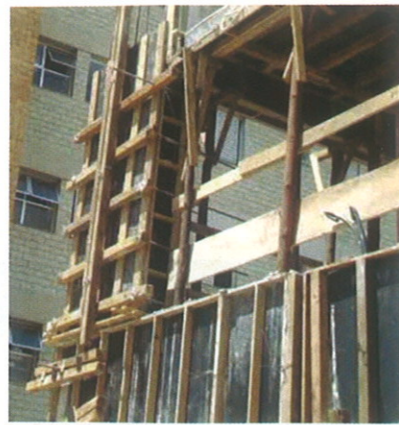
Uma fôrma na fachada requer andaime, afetando negativamente na produtividade
