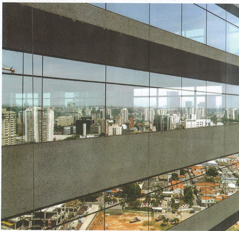
Fixação das fachadas unitizadas de concreto pré-moldado à estrutura periférica
