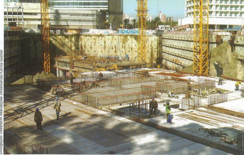
A adoção das lajes alveolares pré-moldadas protendidas permitiu agilizar a execução da torre corporativa
