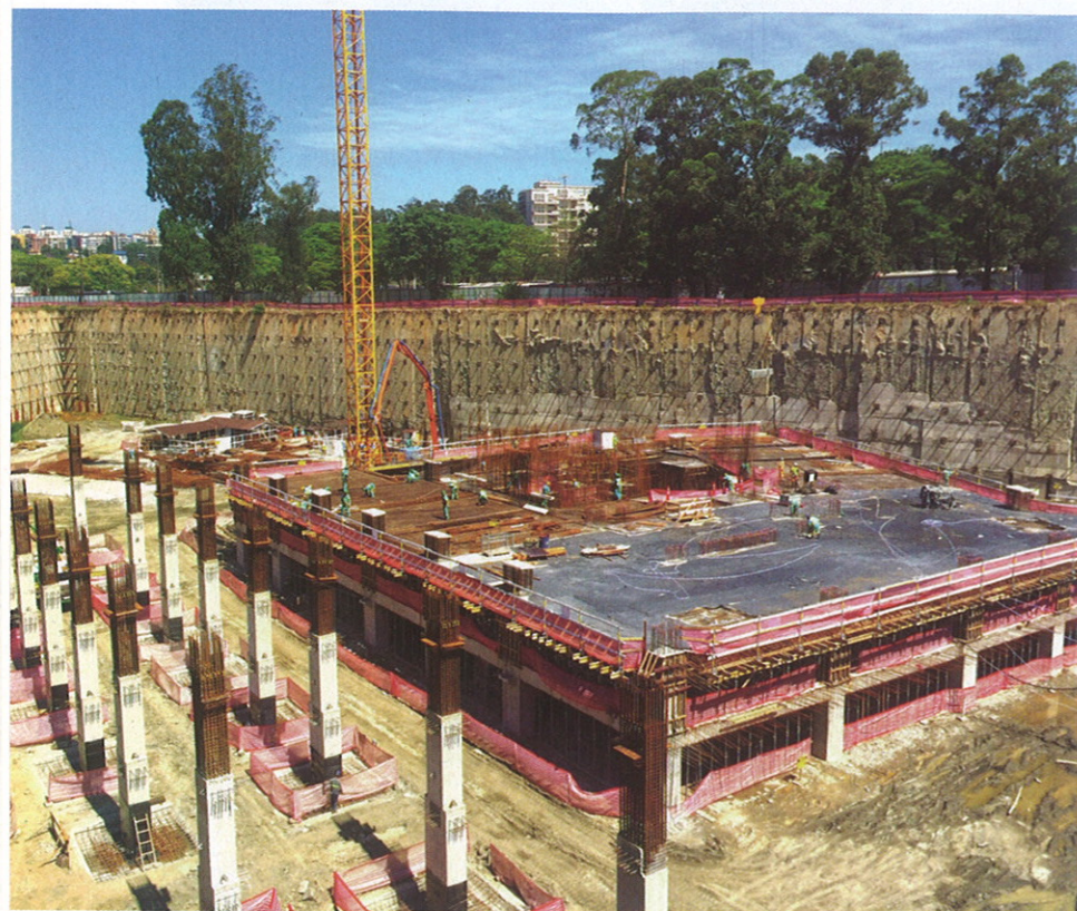
Sistema de contenção da gleba A foi um dos maiores desafios executivos do projeto
