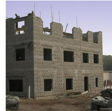
Bloco de concreto (Alvenaria estrutural)
