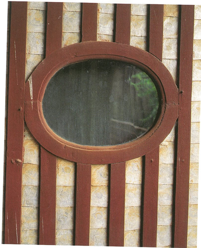
Casa de Eucher Pereira, Benaulim. Pormenor de janela de carepas, placas de madreperola extraída de bivalves, com pequena espreitadeira em vidro. (H.C.)
