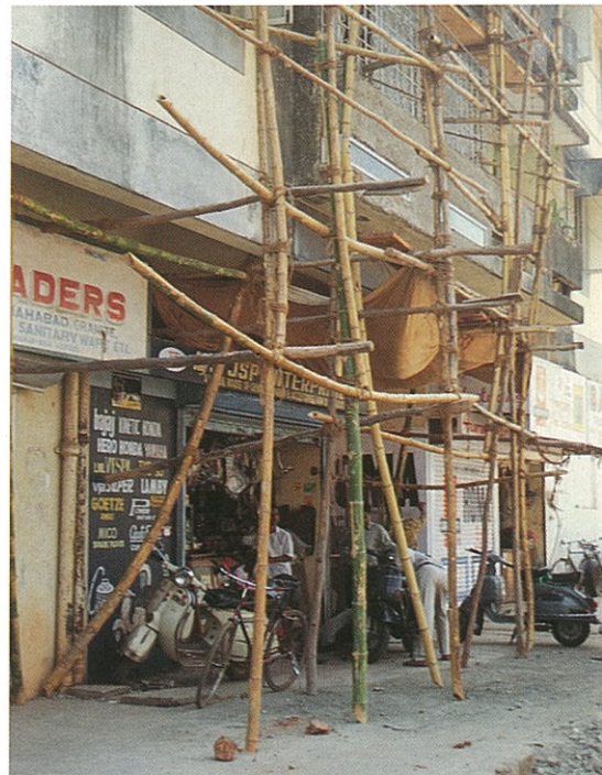
Pangim. Andaimos de bambu utilizados na construção civil. (H.C.)
