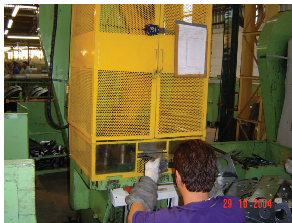
Figura 55 – Fechamentos das zonas de prensagens com proteções móveis e com bloqueio
