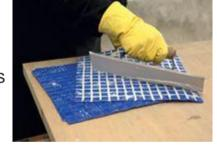
revestimento. Para a aplicação a melhor ferramenta é a desempenadeira de borracha. É importante que, durante o serviço, seja aplicada força para que a massa penetre na profundidade das juntas presentes entre as pastilhas. Os rejuntes cimentícios devem ser aplicados somente passadas 72 horas do assentamento.
