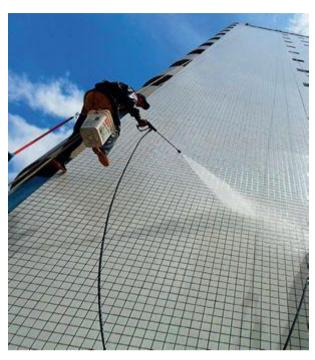
remoção de manchas específicas, deve-se seguir a orientação do fabricante da pastilha.
