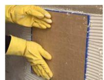
superiores a 1 m². Um erro grave é utilizar a argamassa colante passadas duas horas e meia da adição de água. Na aplicação de pastilhas de vidro transparentes, deve-se passar o lado liso da desempenadeira sobre os cordões antes do assentamento.
