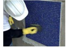
agressivos que podem danificar a superfície da pastilha. A limpeza deve ser feita com uma espuma umedecida em água, com movimentos circulares. Em áreas
