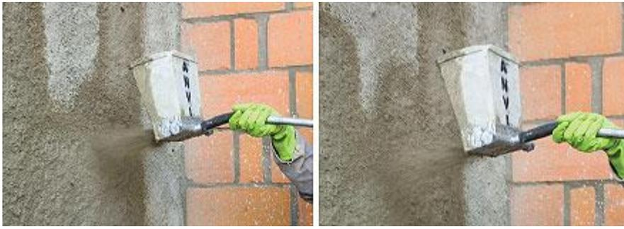
Diferentemente do que acontece no método convencional de aplicação, a energia de lançamento do equipamento é constante, resultando em revestimentos com melhor desempenho
