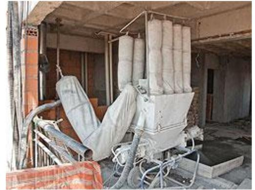
No método a seco, o misturador é posicionado nos andares onde a argamassa será aplicada
