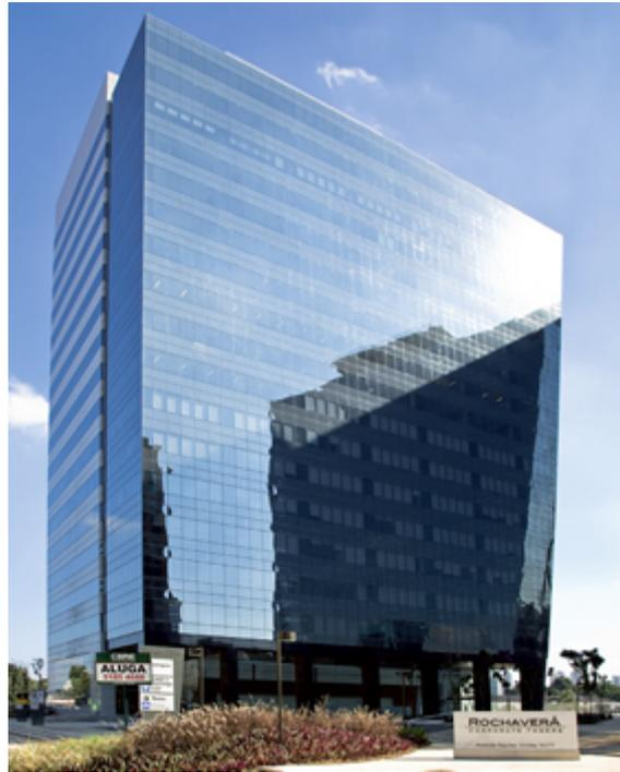
25 fôrmas mesas voadoras foram usadas para concretar as 34 lajes de 1,5 mil m<sup>2</sup> a 2 mil m<sup>2</sup> da torre C do Rochaverá Corporate Towers
