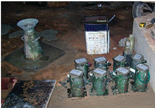
Figura 7 - Nivelamento do terreno para moldagem de corpos de prova de concreto
