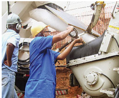
Figura 2 - Coleta de amostra para verificação do abatimento (slump)
