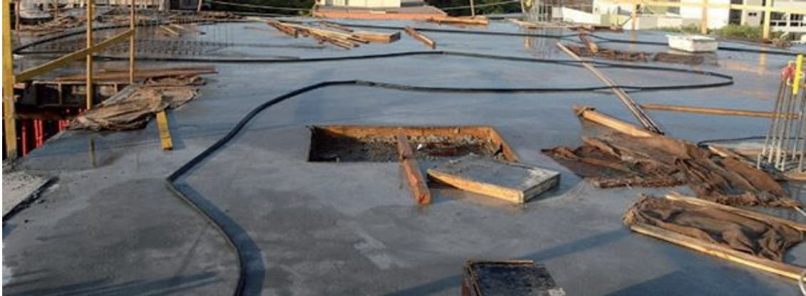
Figura 15 - Cura com mangueiras microperfuradas associadas com sacos de aniagem
