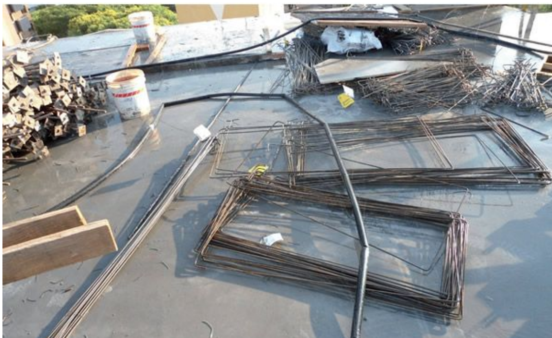
Figuras 17 - Estocagem de aço para montagem de pilares sobre lajes durante o processo de cura do concreto
