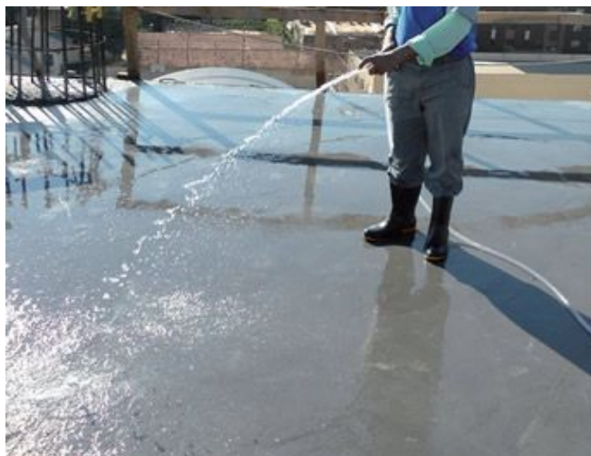
Figuras 2 e 3 - Cura úmida do concreto por molhagem constante
