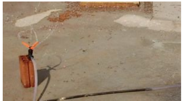
Figura 4 - Aspersor utilizado no processo de cura do concreto
