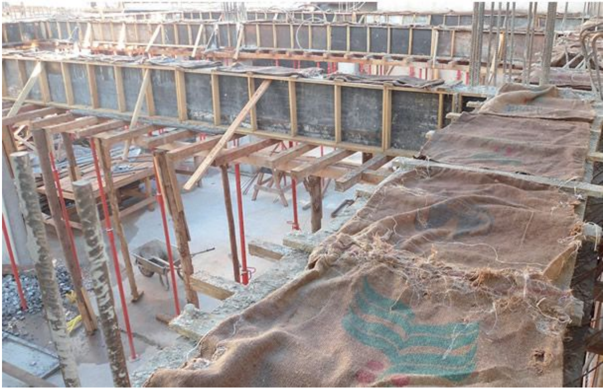
Figura 12 - Cura com sacos de aniagem em locais de difícil acesso
