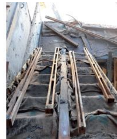
Figuras 10 - Cura de concreto em escada com sacos de anigem
