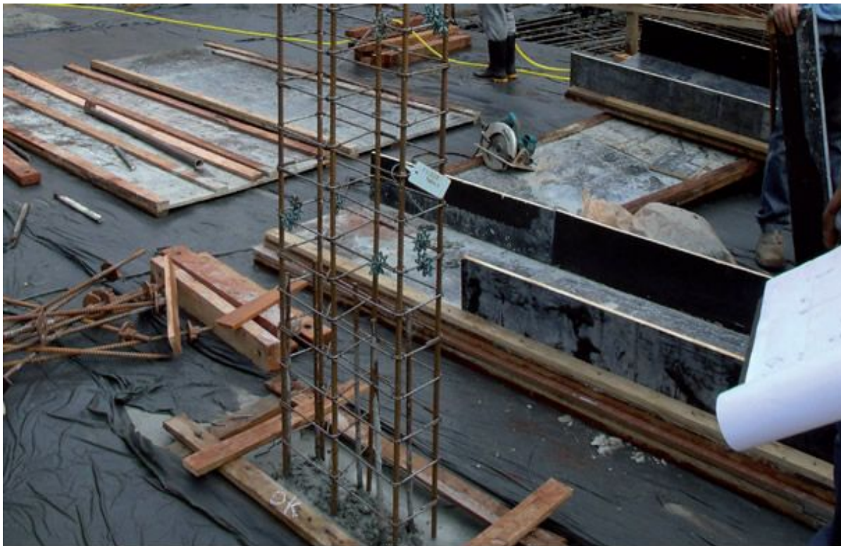
Figura 11 - Cura com manta geotêxtil
