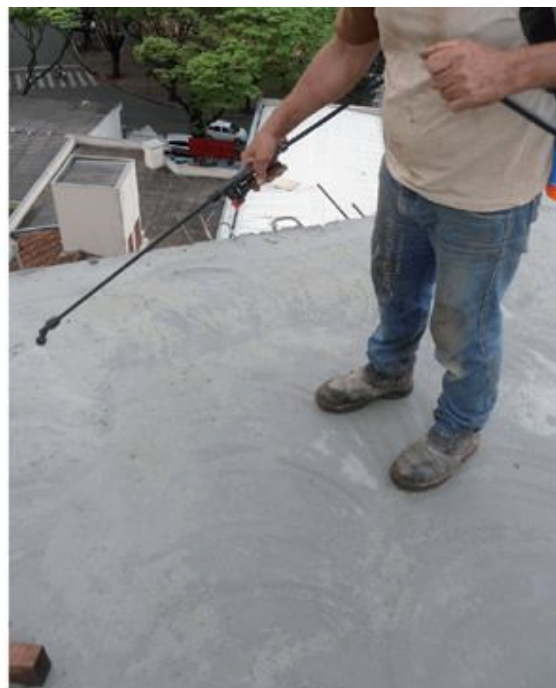
Figuras 13 e 14 - Aplicação de composto formador de membrana para cura com regador e por pulverização
