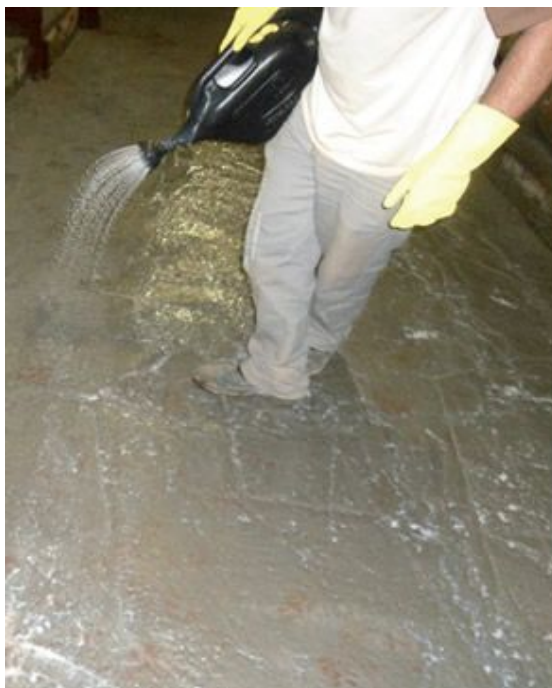
Figuras 13 e 14 - Aplicação de composto formador de membrana para cura com regador e por pulverização
