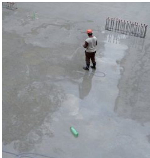
Figuras 2 e 3 - Cura úmida do concreto por molhagem constante
