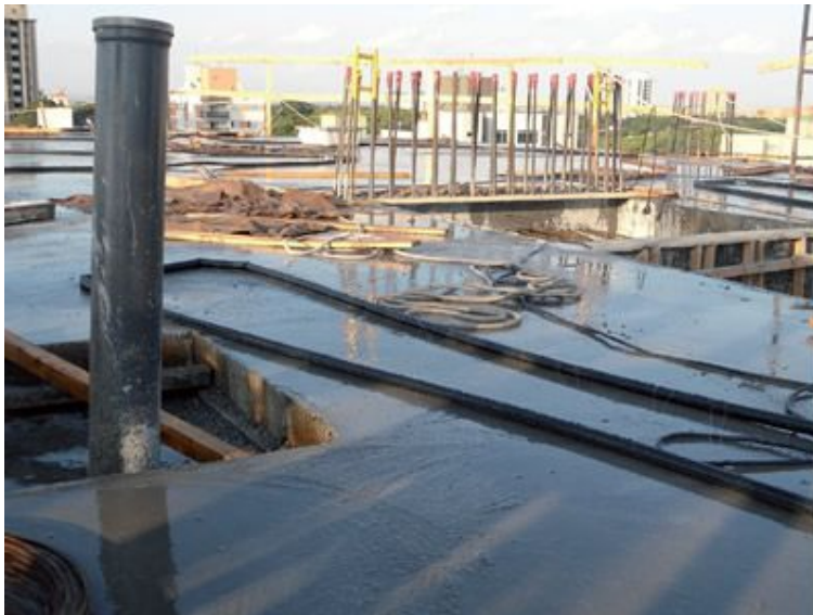
Figuras 7 - Laje submetida à cura com uso de mangueiras microperfuradas de jardim
