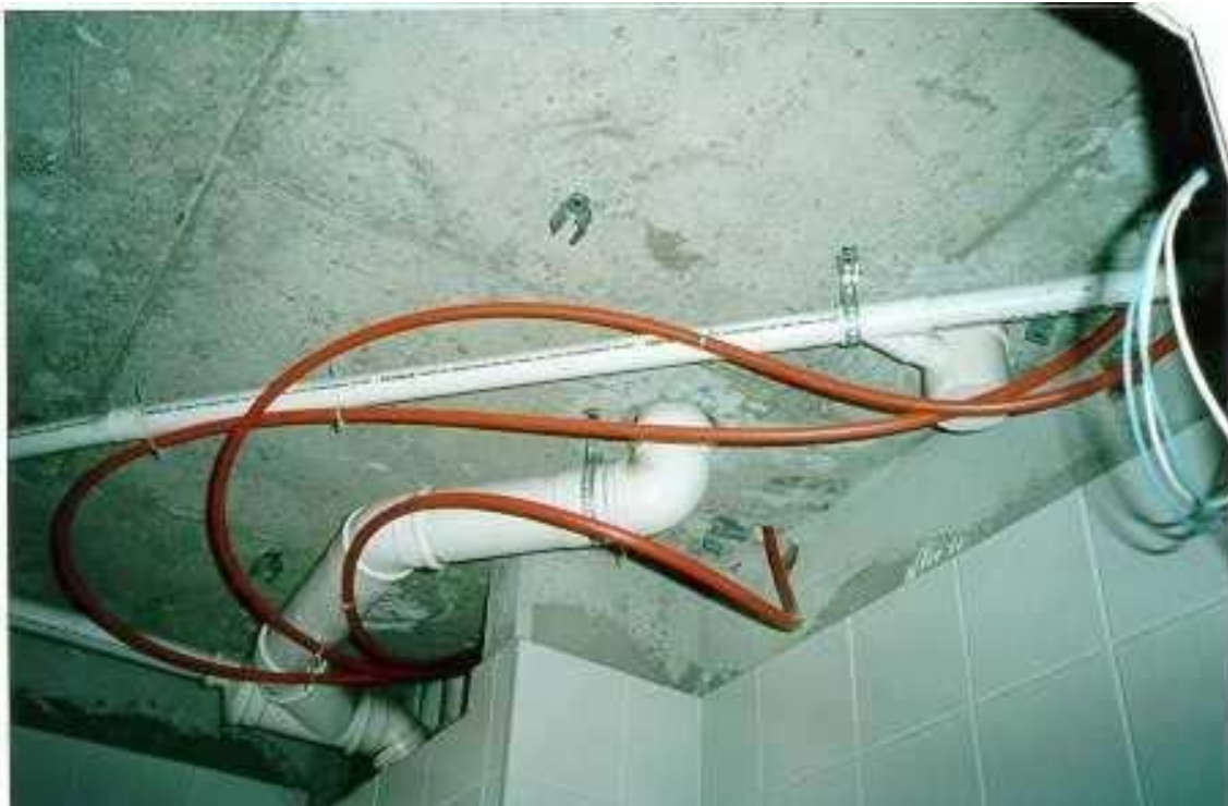
Figura 4.18 – Execução de tubulação de esgoto.
