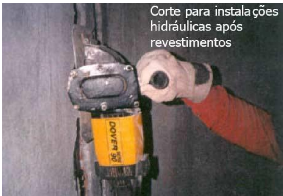
Figura 4.14 – Corte para passagem dos ramais.
