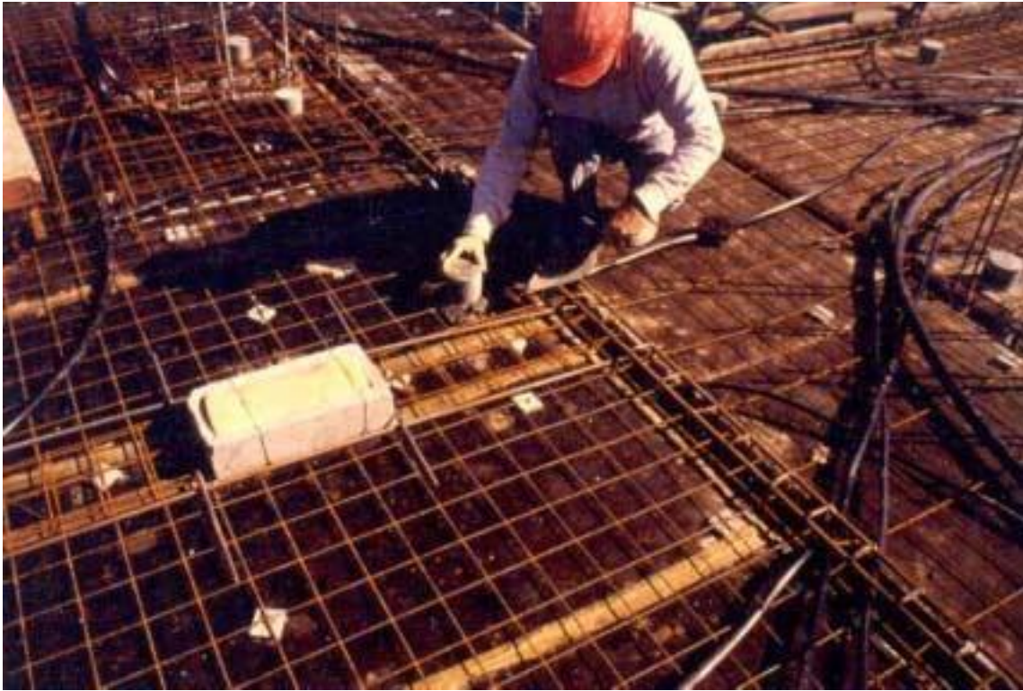
Figura 4.7 – Caixa colocada na fôrma para criar um vazio na laje.
