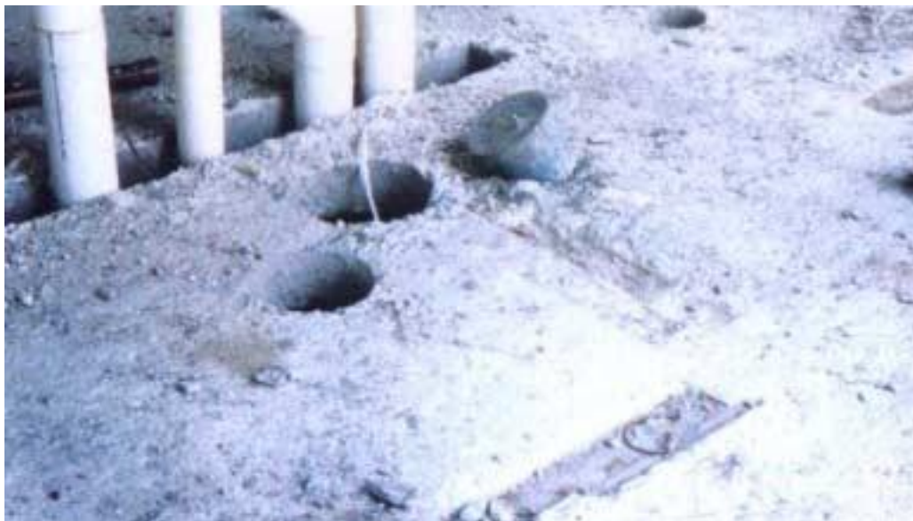
Figura 4.10 – Passagem de tubos por vãos na laje.
