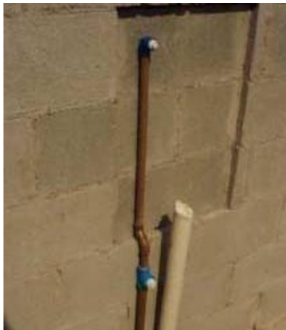
Figura 4.14 – Compatibilização de interfaces para adequação ao revestimento.
