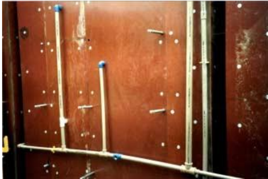
Figura 4.13 – Execução dos ramais em paredes de gesso acartonado.
