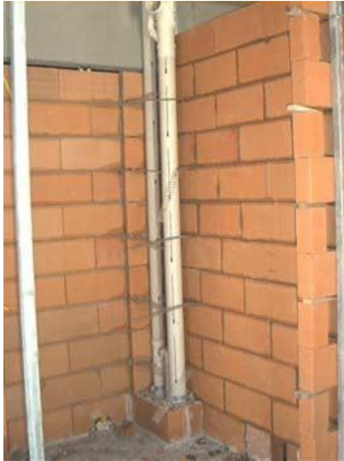
Figura 4.11 – Tubulação já executada e fixada em shaft não visitável.
