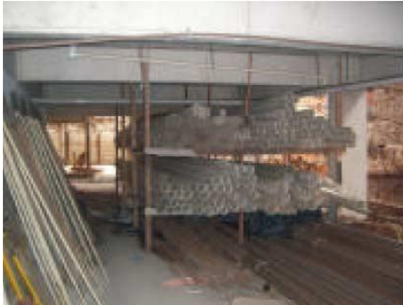
Figura 4.4 – Estoque de tubos para instalações de água e esgoto.
