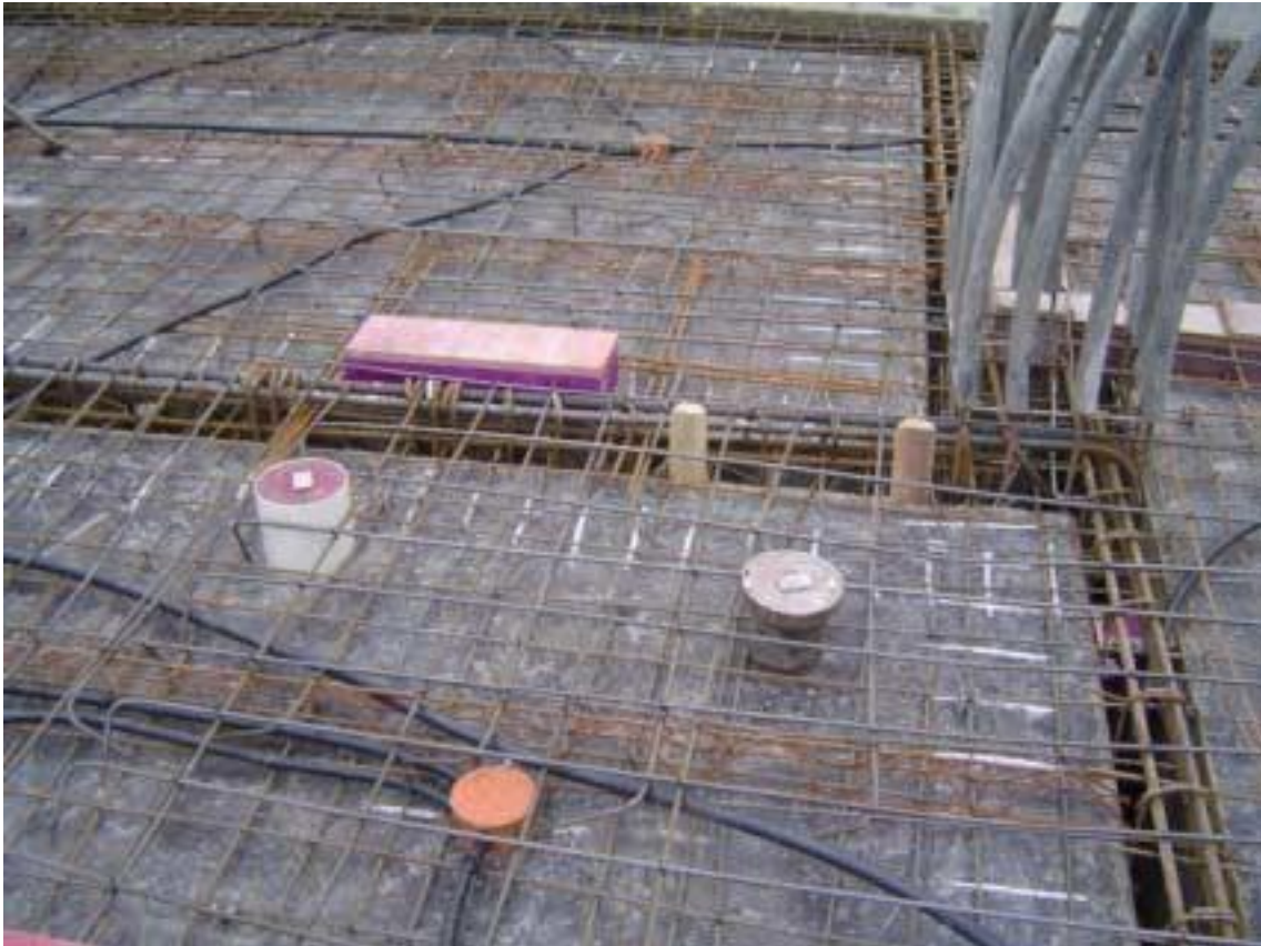
Figura 4.8 – Eletrodutos e caixas de passagem dos sistemas elétricos e marcações para passagens hidráulicas.
