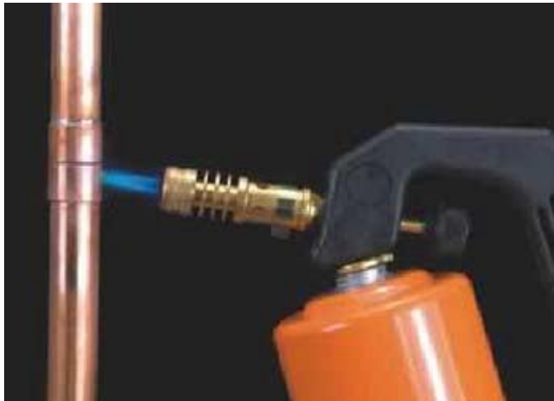
Figura 5.8 - Esquema de união dos tubos de cobre.
