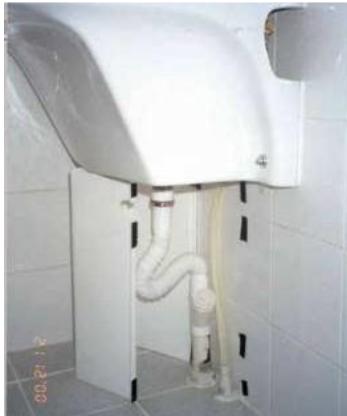
Figura 4.15 – Ramais aparentes cobertos por carenagem.
