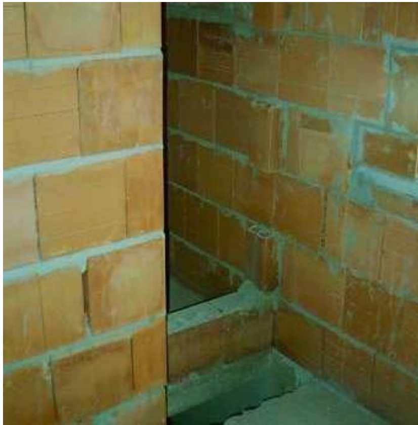
Figura 4.9 – Shaft não visitável e alvenaria semi-pronta.
