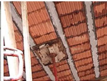
**Figura 18** – Vista da face inferior da laje. O CAA não libera água e não penetra nos espaços entre tijolos cerâmicos contíguos
