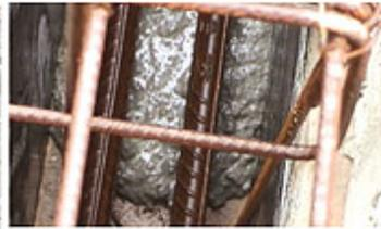
**Figura 15** – Detalhe da movimentação do CAA no interior de uma viga. O concreto não segrega e preenche completamente os espaços entre as armaduras e dessas com as fôrmas
