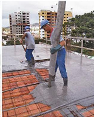
**Figura 9** – Detalhe das operações de lançamento, espalhamento e acabamento
