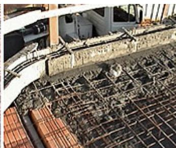
**Figura 4** – Concretagem de vigas invertidas
