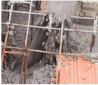
**Figura 14** – Detalhe do lançamento do CAA para preenchimento de uma viga
