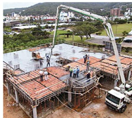
**Figura 2** – Vista geral do pavimento (lajes e vigas) sendo concretado com CAA
