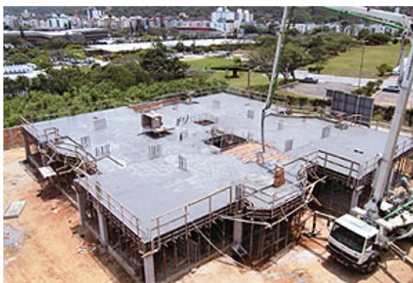
**Figura 19** – Vista geral do pavimento concretado com CAA
