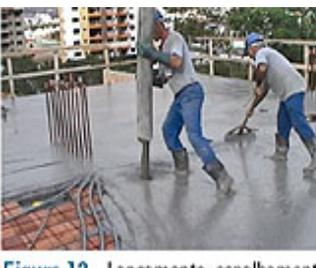
**Figura 12** – Lançamento, espalhamento e acabamento do concreto aplicado sobre trecho de laje mista (vigota-tijolo)
