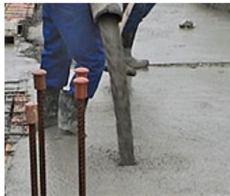
**Figure 17** – Detalhe do CAA, homogêneo e sem segregação
