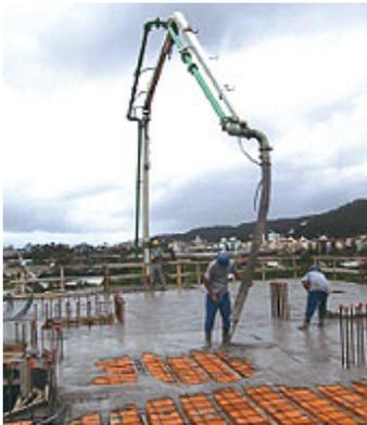
**Figura 8** – Uso da lança na concretagem. Somente dois operários encarregam-se do serviço
