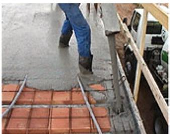
**Figura 11** – Preenchimento de uma viga com CAA
