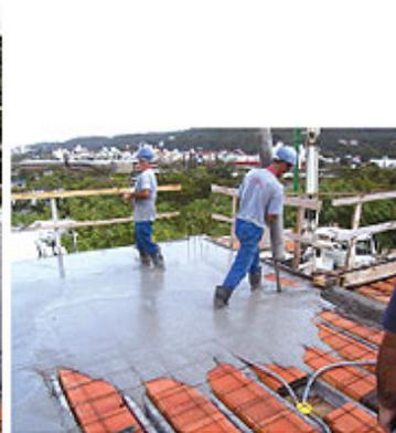
**Figura 10** – Lançamento do CAA na laje mista, onde se verifica a característica autonivelante do concreto
