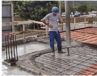
**Figura 16** – Aplicação do CAA em um trecho de laje maciça, mostrando a viga invertida previamente concretada
