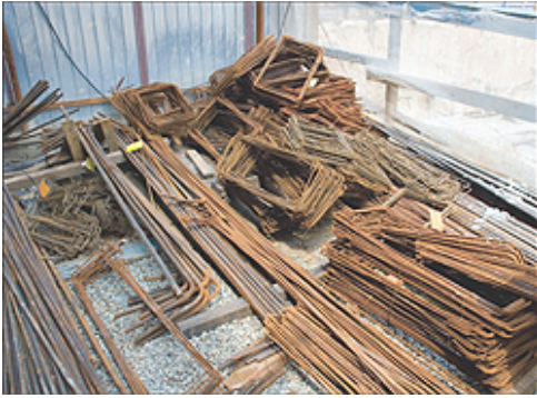
Para evitar problemas de gerenciamento das peças prontas, construtora procura trabalhar no modelo just-in-time
