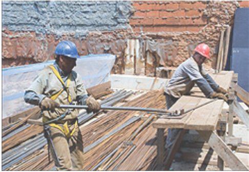
Mesmo comprando aço cortado e dobrado em fábrica, construtoras mantêm uma pequena central de corte e dobra no canteiro para contornar as emergências
