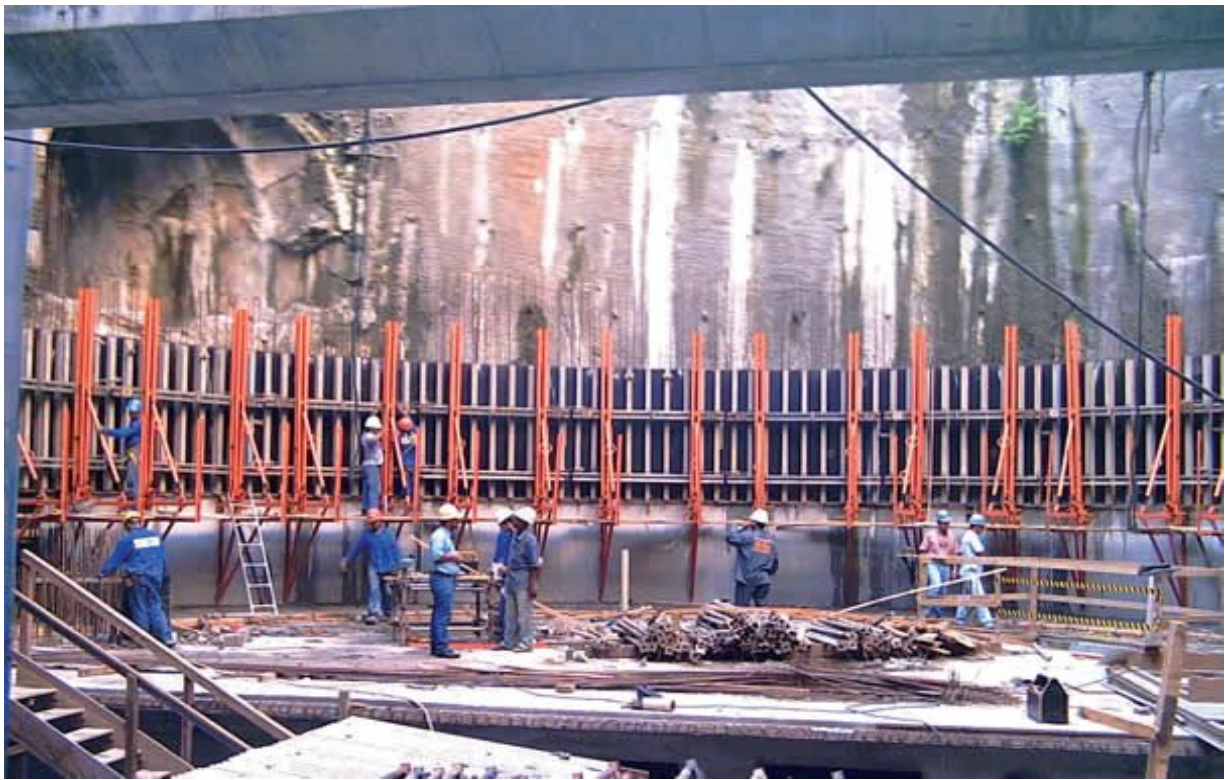
Figura 2 - Tecnologia atende estruturas de concreto verticais de grande altura, em locais onde a concretagem em apenas uma etapa é inviável e a instalação de andaimes, onerosa demais
