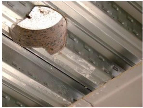
**Figura 7** - Armaduras de reforço devem ser colocadas nas aberturas especificadas em projeto
