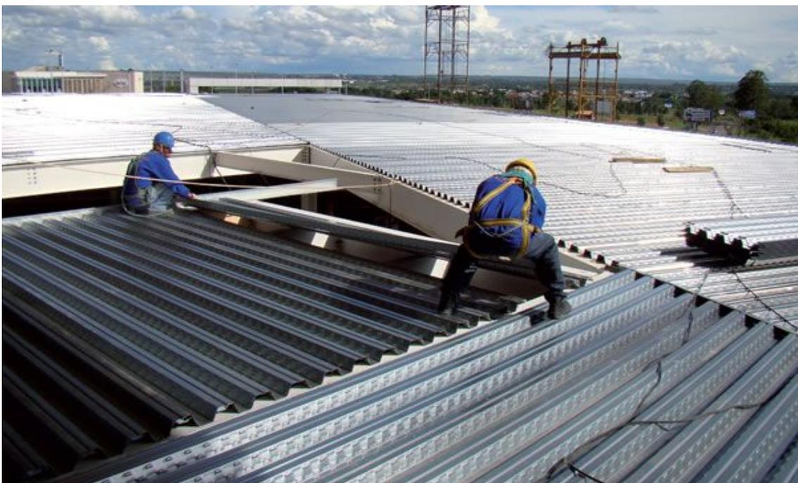
**Figura 8** - Painéis posicionados e alinhados
