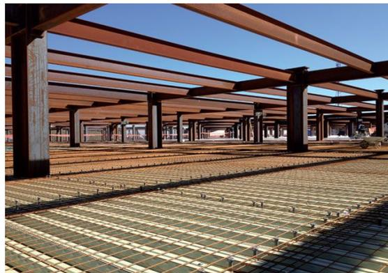
**Figura 11** - Montagem das telas e dos conectores
