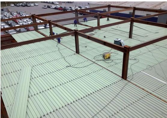
**Figura 10** - Montagem e aplicação dos conectores
