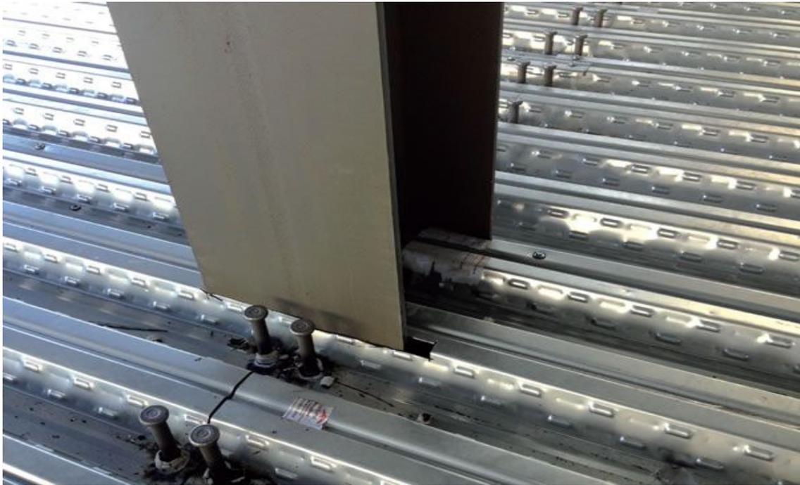
**Figura 9** - Ajustes, como os recortes ao redor dos pilares, devem ser feitos para adequar a fôrma à geometria do edifício
