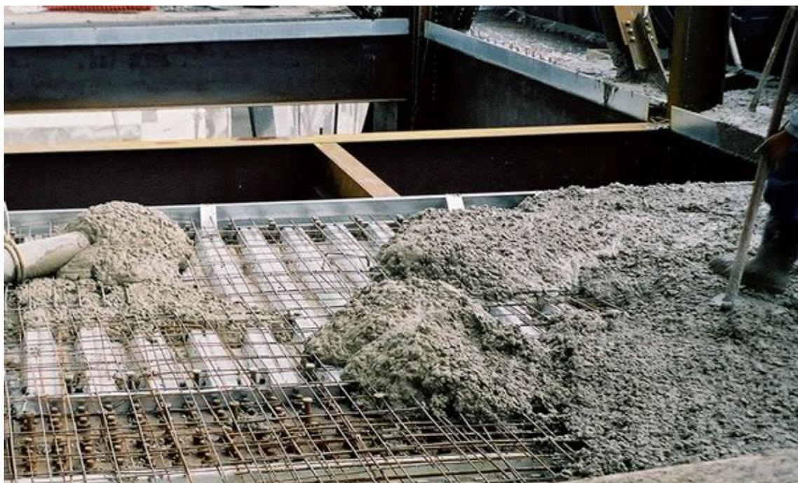
Figura 12 - Concretagem da laje
