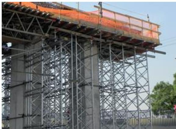
O escoramento pode ser feito com escoras pontuais ou torres de encaixe, com travessas horizontais e diagonais para estabilização
