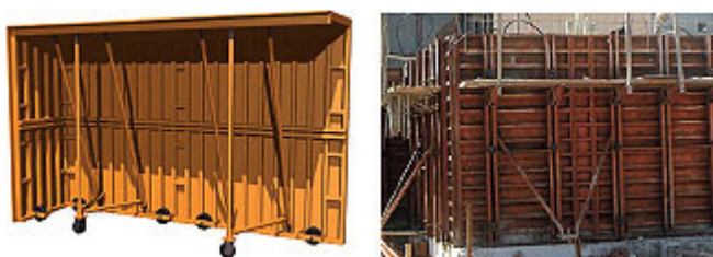
Sistema tipo túnel com fôrmas metálicas
