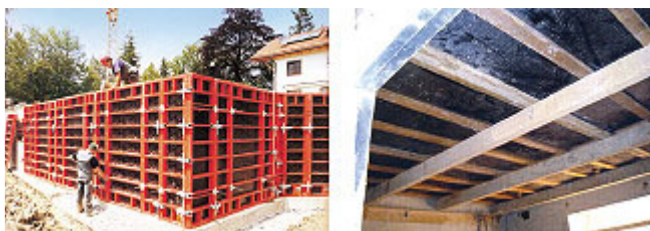
Fôrmas de madeira com travamento metálico
