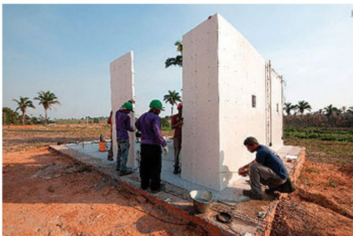
Montagem das paredes - vista externa do molde
