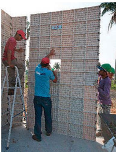
Montagem das paredes - vista interna do molde
