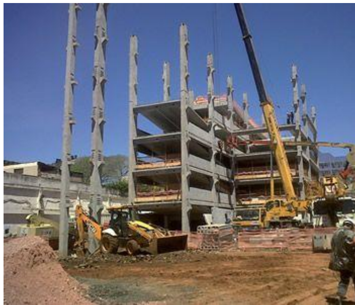
Com 38,6 mil m 2 construídos, o edifício garagem do Shopping Praia de Belas, em Porto Alegre, utilizou pilares, lajes, escadas, painéis alveolares e placas de acabamento pré-fabricadas. A obra foi concluída em sete meses
