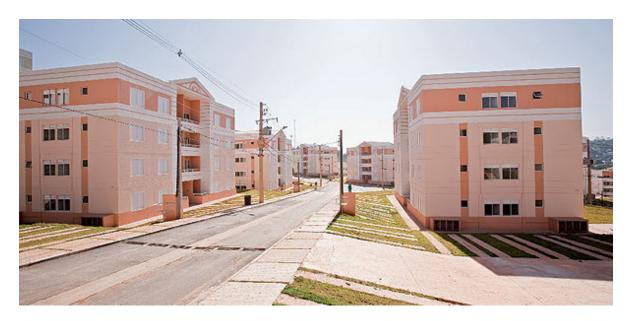
Para viabilizar os 128 edifícios e 320 casas do Condomínio Villa Verde Cotia, a Tenda assimilou a técnica construtiva de paredes de concreto moldadas com fôrmas de alumínio
