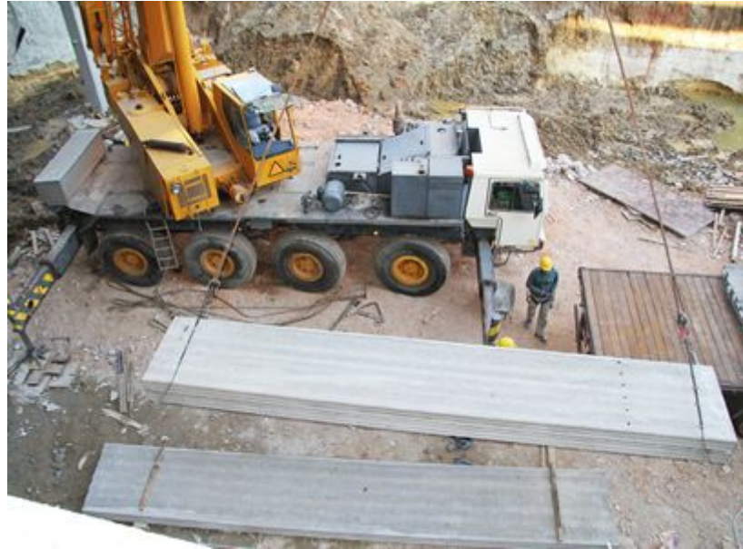
Figuras 6 e 7 - Para estruturas mais baixas, o içamento das peças pode ser feito por guindastes ou caminhão munkk
