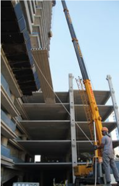
Figuras 6 e 7 - Para estruturas mais baixas, o içamento das peças pode ser feito por guindastes ou caminhão munkk
