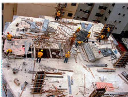
Início da montagem dos pilares (pavimento-tipo)
