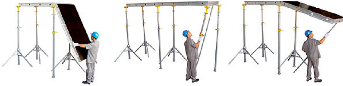
Esquema de funcionamento do sistema drophead
