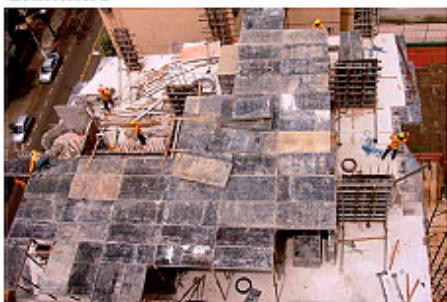
Montagem do assoalho com fôrma para lajes em alumínio
