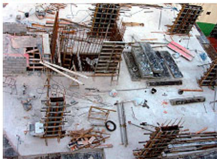
Pilares prontos no segundo dia
