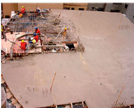
Início e fim da concretagem no quinto dia
