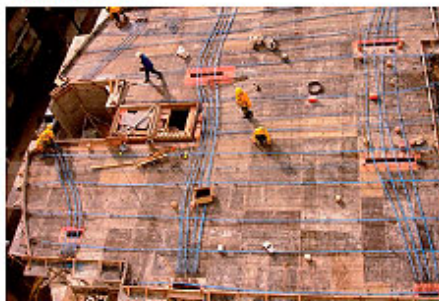
Lançamento das cordoalhas que se repetem em todos os tipos, tela soldada e CA-50/60
