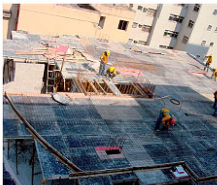
Colocação dos arremates prontos
