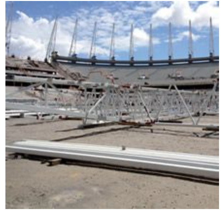
Depois de montados, os joists aguardam alinhamento final. Após a checagem, o módulo é içado até a sua posição definitiva
